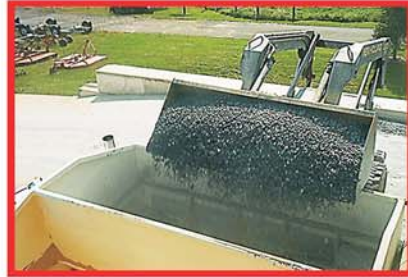
Cargar la tolva de áridos
